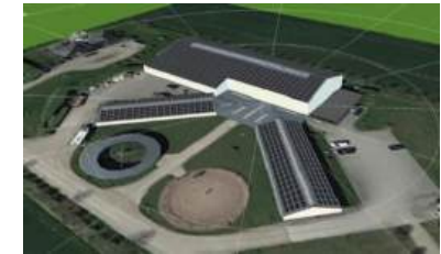
Schleswig-Holstein voraussichtlich 264 kWp
