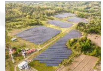
Philippinen Projektrechte, Freifläche 25 MWp
