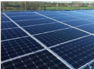
Deutschland Abbau Anlage 577 kWp
