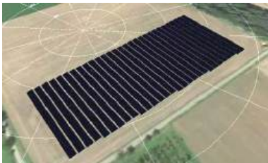
Bayern voraussichtlich 8.327 kWp
